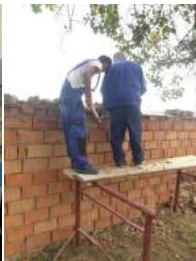
Oprava zámecké zdi
