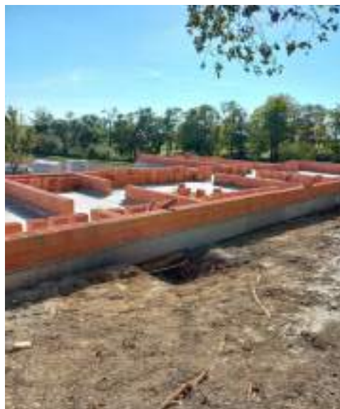
Výstavba zahradního centra
