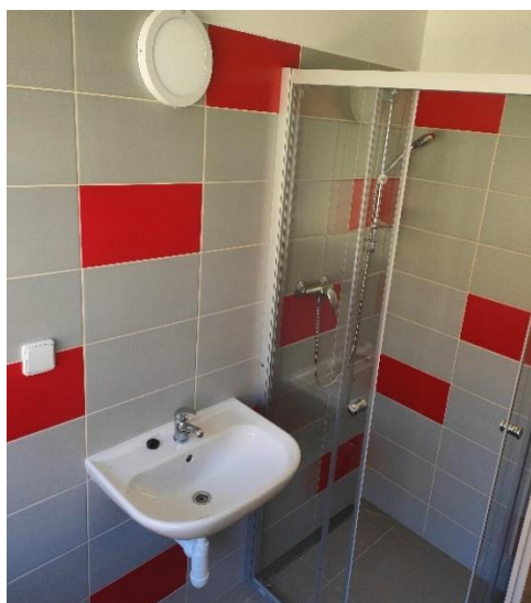
Nově zrekonstruované koupelny
