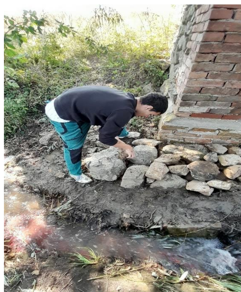
Oprava zámecké zdi v parku VÚ
